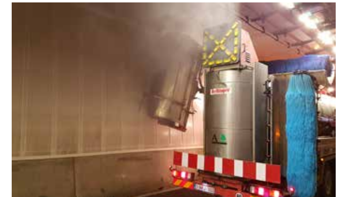
De wandplaten worden gereinigd met een combiwagen.
